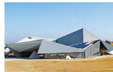
第一回隈木造・木質化建築賞大賞(九州芸文館アネックス2)
